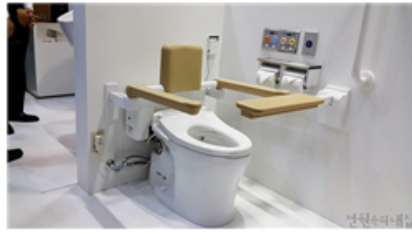
도교복지기전전시회에 전시된 장애인 화장실로 변기 정면에 몸을 기댈 수 있는 수직이동형 안전바를 설치해 놓은 것이 특징
