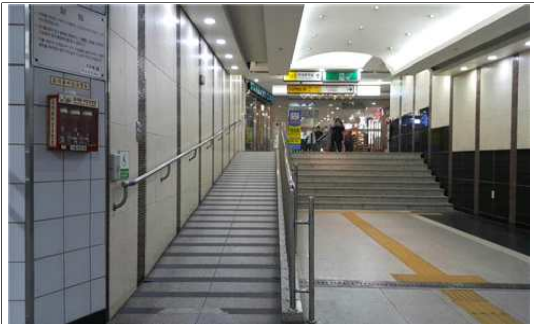
양쪽에 손잡이를 설치한 완만한 경사로와 도움요청 벨도 설치되어 있어서 장애인이 도움이 필요할 시 다양한 편의시설을 사용 가능하다.
